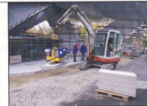
Großbaustelle mit Probst-Maschinen
