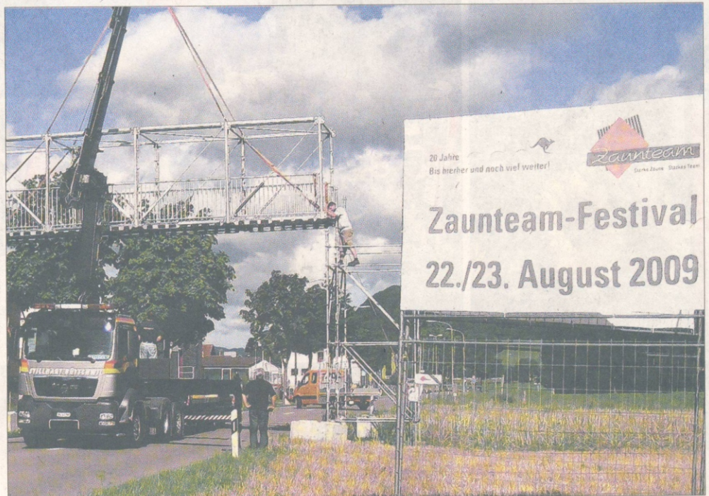
Die Fussgängerpasserelle soll den Besuchern den problemlosen Übergang vom Fest- zum Firmenareal ermöglichen. Mit den Aufbauarbeiten wurde bereits einen Monat vor dem Spektakel begonnen. (Bild zvg)
